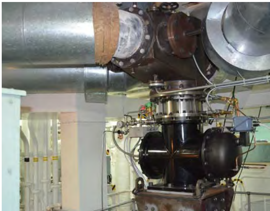
図4 排熱回収スターリングエンジン
